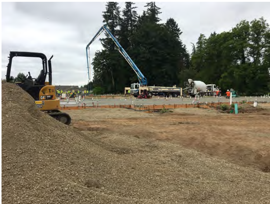
Slab Pour at Heartfelt Guest House
